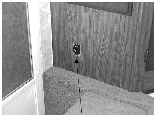
Aux. Battery Switch
